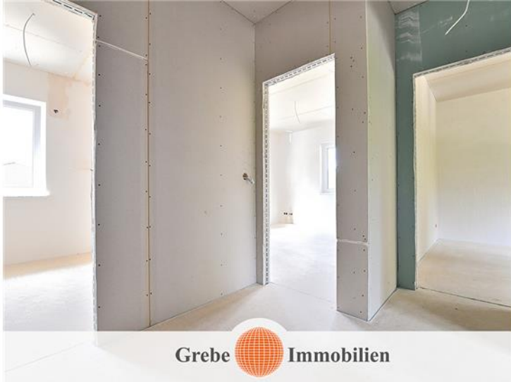
Flur im DG
